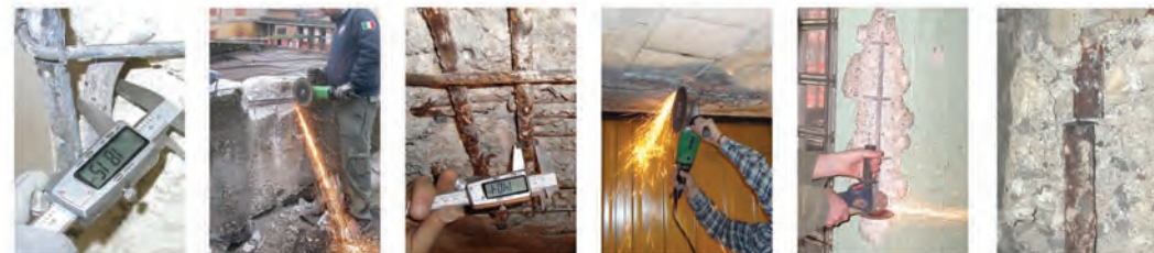
ANALISI DEL POTENZIALE DI CORROSIONE DI FERRO D'ARMATURA PROVA A TRAZIONE DI BARRA D'ARMATURA
